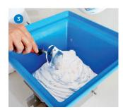
Durch die zusätzliche Wasserzugabe wird der Rigips ProMix Plus noch geschmeidiger und verfügt über hervorragende Verarbeitungseigenschaften für das Arbeiten mit dem Rigips Auftragsbehälter.
