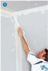
Die zugeschnittenen Rigips Levelline Profile werden zügig durch den Auftragsbehälter gezogen und direkt auf die jeweilige Ecksituation aufgebracht.
