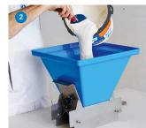
Unter Zugabe von ca. 100 ml Wasser pro 5 kg Spachtelmasse wird der Rigips ProMix Plus gut durchgerührt und dann in den Rigips Auftragsbehälter eingefüllt.
