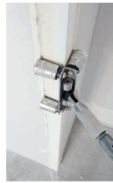
Anpressen mit dem Rigips Außenkantenroller 90°. Durch die leicht konische Rollenstellung wird die überflüssige Spachtelmasse nach außen gedrückt.
