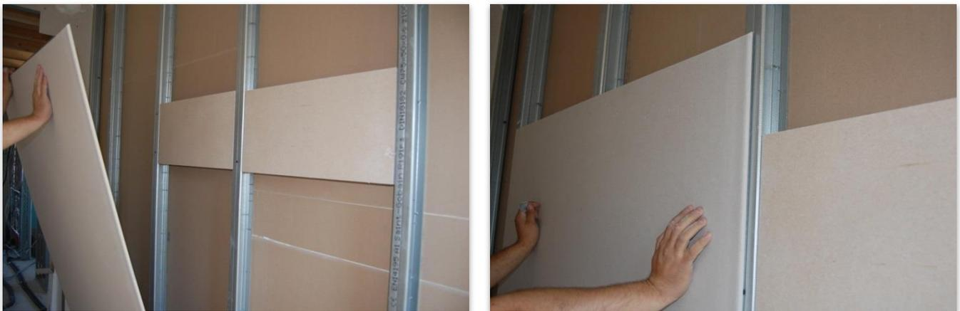
Bild 7: Ansetzen der ersten Beplankungslage
