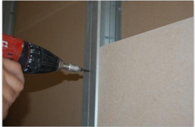
Bild 4: Fixierung der Rigips Traverse im offenen Profil
