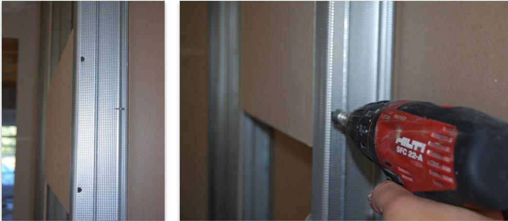
Bild 6: Befestigung der Rigips Traverse auf der gegenüberliegenden Profil-Seite
