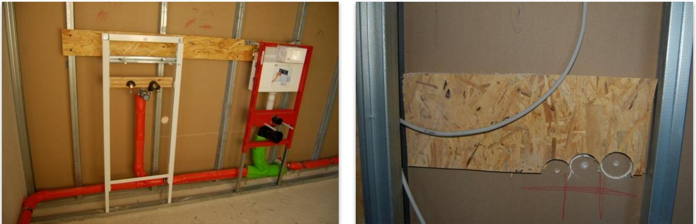
Bild 1: Bauübliche Traversen in Trockenbauwänden
