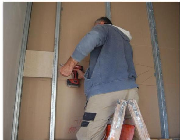
Bild 3: Einfaches Kürzen der Rigips Traverse bei Profilabständen < 625 mm
