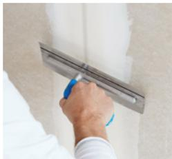
Komplett ausgefüllte Spachtelfuge (von oben) mit planebenem Ergebnis.
