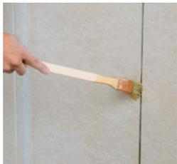
**Vorspachteln:** VARIO Fugenspachtel mit Spachtel oder Glättkelle ausdrücken. VARIO Fugenspachtel quer zur Fuge einbringen und flächenbündig abziehen. Löcher und Fehlstellen mit Fugenspachtel ausdrücken und Schraubenköpfe überspachteln.
