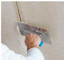
**Nachspachteln:** Erst nach Aushärtung der Vorspachtelung darf weiter gearbeitet werden. Die Nachspachtelung mit dem gleichen Fugenmaterial der Vorspachtelung aufbringen oder Rigips Fertigspachtel (ProMix Finish) verwenden.
