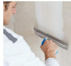
Oberflächenbündig ausgearbeitete Fuge mit flächenebenen Ergebnis und Verspachtelung der Schraubenköpfe und eventueller Schadstellen.
