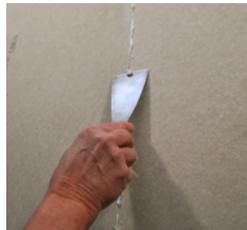
Der Verbrauch an Fugenkleber beträgt ca. 14 ml pro Meter Fuge.
