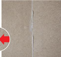
Überschüssiger Fugenkleber quillt aus der Fuge heraus und wird nach Aushärtung mit einem Spachtel abgestoßen.
