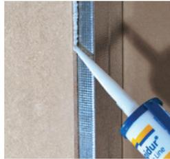
Die nächste Platte mit max. 1 mm Fugenspalt an die erste andrücken. Beim Zusammenpressen muss der Fugenkleber die gesamte Fuge ausfüllen.
