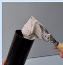
Den fertig (etwas dünner) angerührten VARIO Fugenspachtel zügig in die leicht schräg gestellte Kartusche einfüllen.
