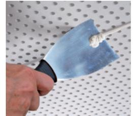
Nach mindestens 24 Stunden Trocknung sind die Fugenbereiche und überspachtelten Schraubenköpfe schleifbar und für die gewünschte weitere Oberflächenbehandlung vorbereitet.
