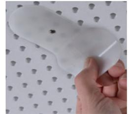
Im Nachgang den leicht angezogenen Rigitone Mix vorsichtig mit dem Rigidips Stielspachtel abstoßen und die Fugen anschließend in entgegengesetzter Richtung mit dem Spachtel glattstreichen.
