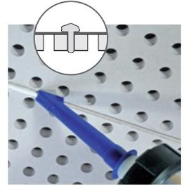
Die Schraubenköpfe leicht erhöht mit Hilfe der Rigidips Schraubenkopfschablone überspachteln.
