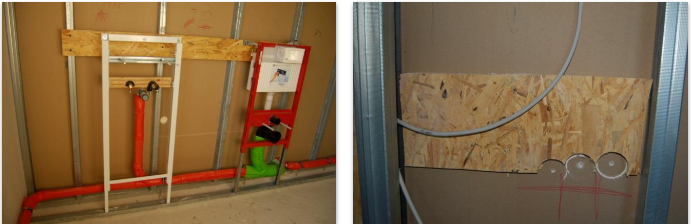
Bild 1: Bauübliche Traversen in Trockenbauwänden
