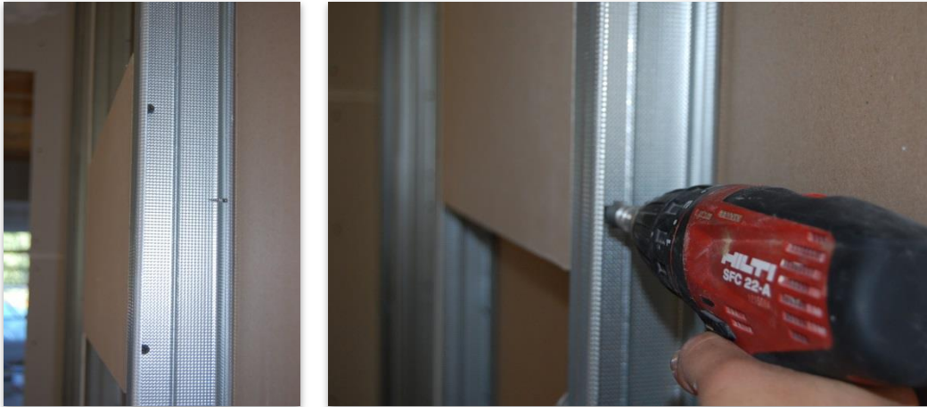
Bild 6: Befestigung der Rigips Traverse auf der gegenüberliegenden Profil-Seite
