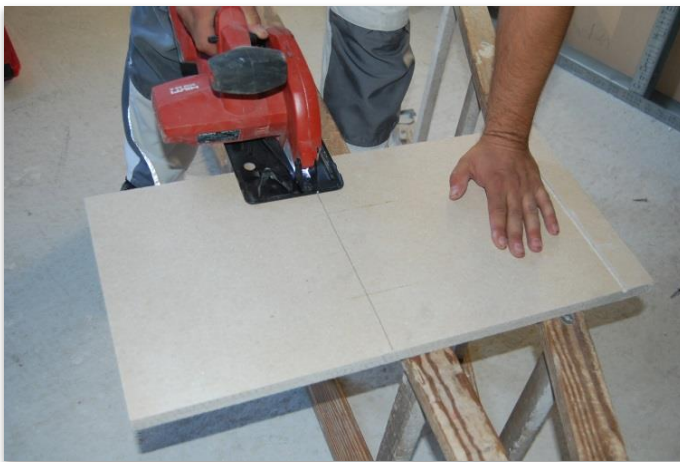
Bild 3: Einfaches Kürzen der Rigips Traverse bei Profilabständen < 625 mm
